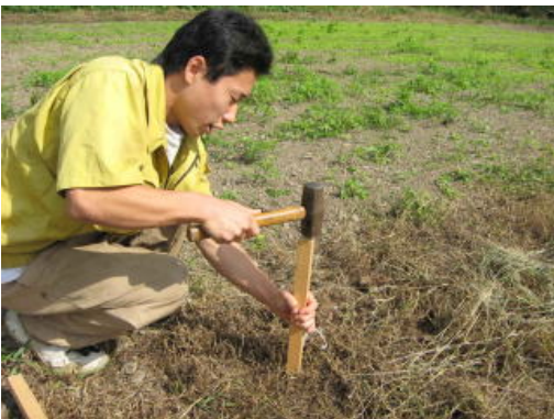
①杭を打ち込み基準点を作ります。
